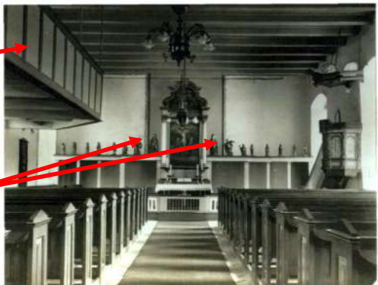
Ketting kirke 1927. Da fjernede man sidevingerne fra alterpartiet og sammenbyggede sidepartierne med alteret
